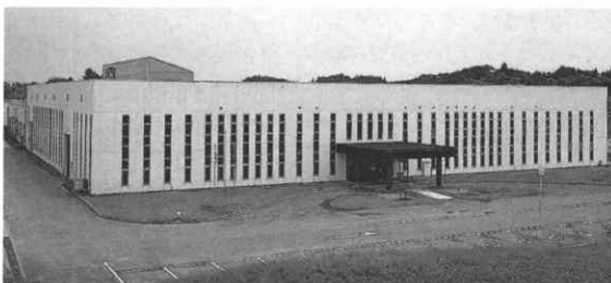
東京工装株式会社福島工場
